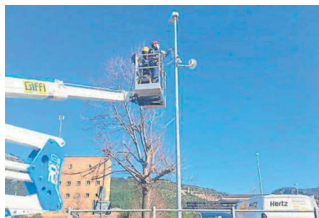
I lavori per l'installazione di nuove telecamere a Sezze nella zona del parcheggio della stazione
